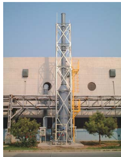
電子部品製造工場 (酸性ミスト処理)
