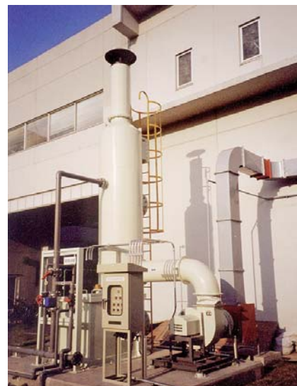
研磨工場 (煤塵処理)
