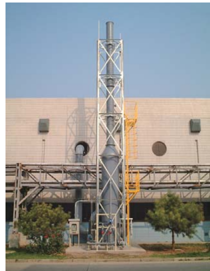
電子部品製造工場 (酸性ミスト処理)
