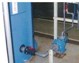
薬品配管フレキシ施工前
