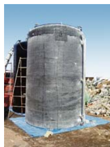
FRP 老朽化対策 （地震対策）前
